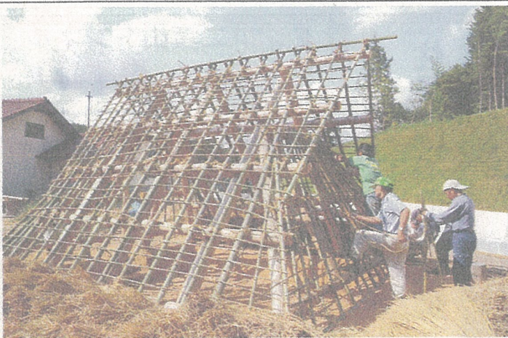
骨組みがほぼ完成した竪穴住居
